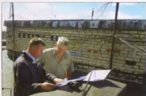
Осуществление строительного контроля на доме 13 по пр. 50 лет Победы в Тутаеве (2015 г.)
