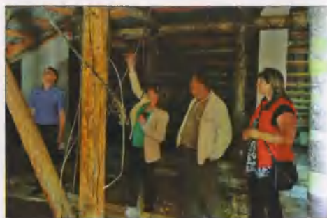
Комиссия принимает капремонт крыши дома 22 по ул. Богдановича г. Ярославль (2015 г.)
