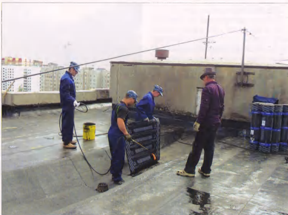
При ремонте плоских крыш используется прочный строительный материал — унифлекс. Ремонт крыши дома 62 к. 5 по Ленинградскому пр. г. Ярославль (2015 г.)
